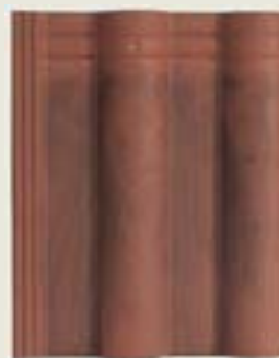
Povrch tradiční střešní tašky: silně znečištěný
